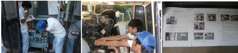
①油圧ユニット(制動機)取扱説明 ②新人による予備原動装置の操作 ③予備原動装置の取扱資料（内部資料）
